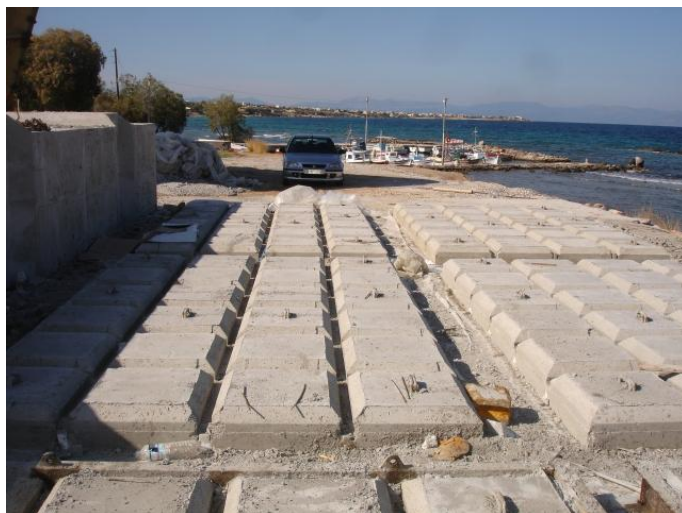
Εικόνα 5-1: Κλίση σκυροδέτησης στρωμάτων κυβολίθων
