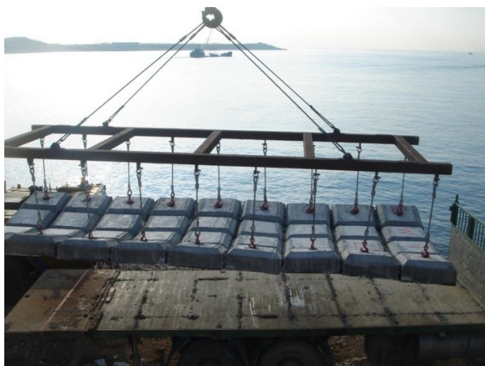
Εικόνα 5-2: Σύστημα ανάρτησης κυβολίθων
